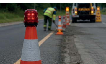
MANTENIMIENTO DE VÍAS
